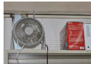
サーキュレータで空気を循環する
